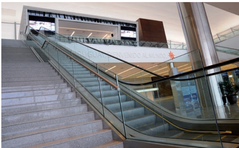
Barandas en el nuevo Aeropuerto Internacional de Carrasco
